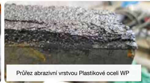
WP – Oprava výstelky skluzu v drtiči a ochrana proti opotřebení
