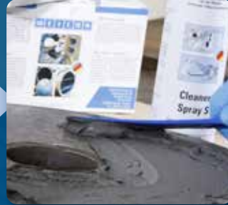
Traitement des composants mélangés
