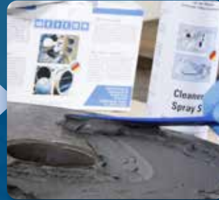
Traitement des composants mélangés
