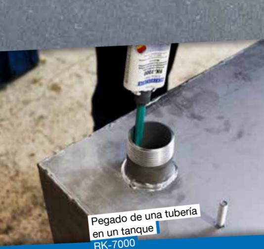
Pegado de una tubería en un tanque
