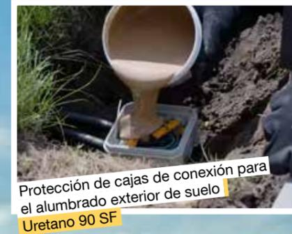
Protección de cajas de conexión para el alumbrado exterior de suelo
