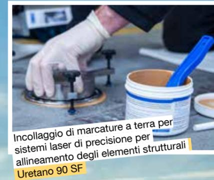
Incollaggio di marcature a terra per sistemi laser di precisione per allineamento degli elementi strutturali Uretano 90 SF
