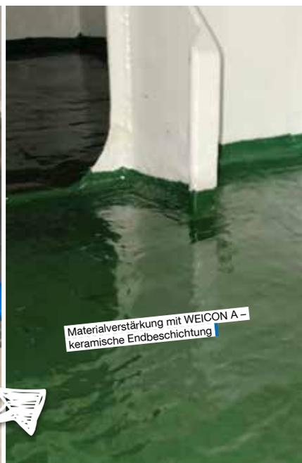
Materialverstärkung mit WEICON A – keramische Endbeschichtung
