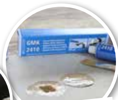
Repararea unei copertine GMK 2410
