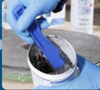
Hars en harder goed en zonder luchtbelletjes vermengen
