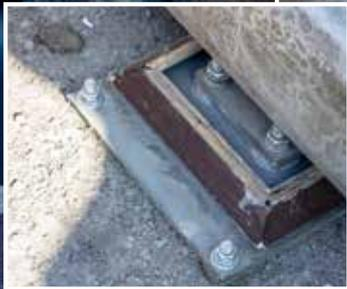
Sistema especial de resina epóxi para construção de calços, apoios em instalações de difícil nivelamento.
