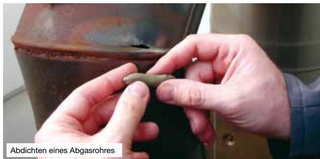
Abdichten eines Abgasrohres
