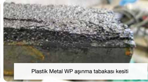
WEICON WP - Sağ değirmen oluğunun astar onarımı & aşınma koruması
