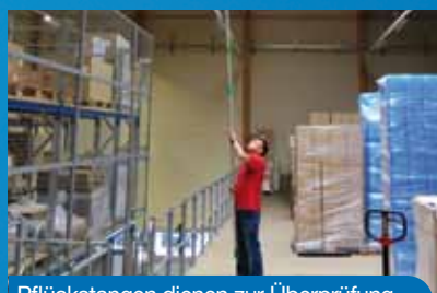
Pflückstangen dienen zur Überprüfung von Rauchmeldern in großer Höhe.
