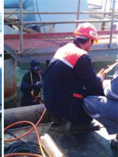
Bei den Arbeiten an den Brückenpfeilern mussten Fugen und Nuten dauerhaft abgedichtet und vor eindringendem Seewasser geschützt werden. An Stellen mit Schweißnähten wurden zur Sicherheit zusätzlich Gummiringe zur Abdichtung eingesetzt.
