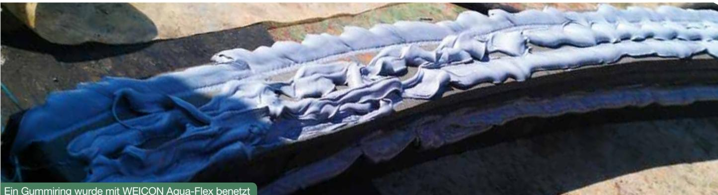
Ein Gummiring wurde mit WEICON Aqua-Flex benetzt
