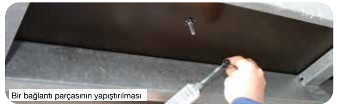
Bir bağlantı parçasının yapıştırılması
