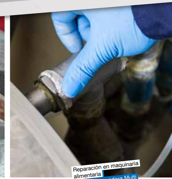
Reparación de una bomba Masilla Reparadora Acero
